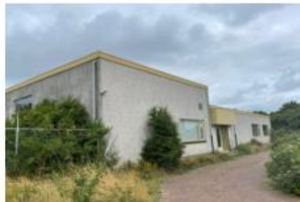
Dakrand slooppand: goede huisvesting voor vleermuizen
