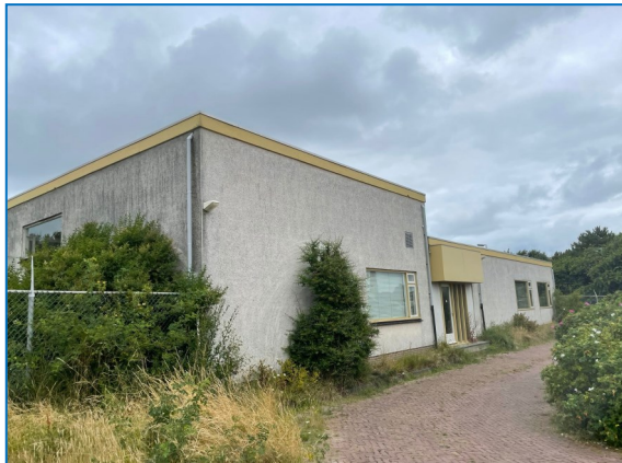
Fig. 3.3: Impressie van het plangebied. Zuidzijde van het gepland te slopen pand.
