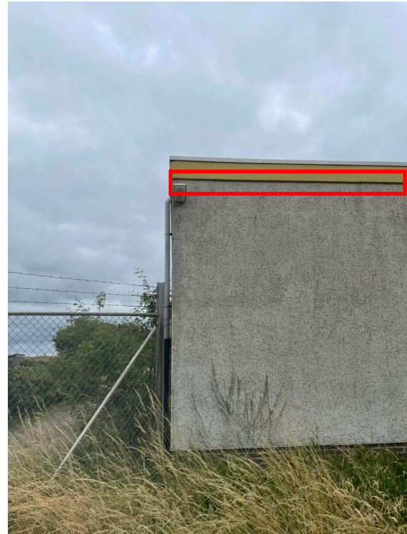
Fig. 3.11: Zuidzijde van het aanwezige pand. Het pand is toegankelijk voor vleermuizen binnen het rood gearceerde deel.
