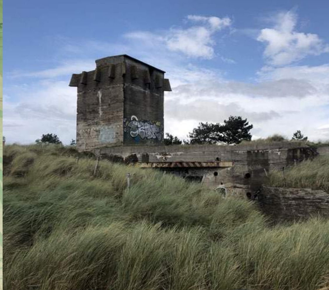
In de Grafelijkheidsduinen ligt een stelsel van bunkers. De bekendste is de kroontjesbunker, die vanwege de vorm zo wordt genoemd. De bunker is een zeldzaam type. (bron: Lisa Timmerman)
