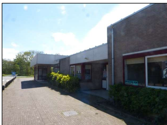
Afbeelding 2.18. Noordzijde van het U-vormige gebouw (vervolg).
