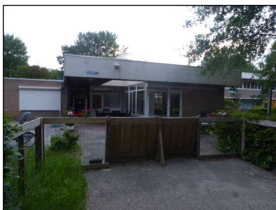
Afbeelding 2.24. Oostzijde van oostelijk gelegen complex.
