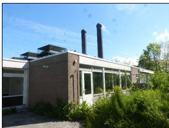
Afbeelding 2.19. Zuidzijde van het U-vormige gebouw.
