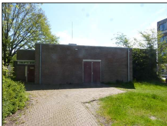
Afbeelding 2.4. Westzijde uitbouw zwembad.
