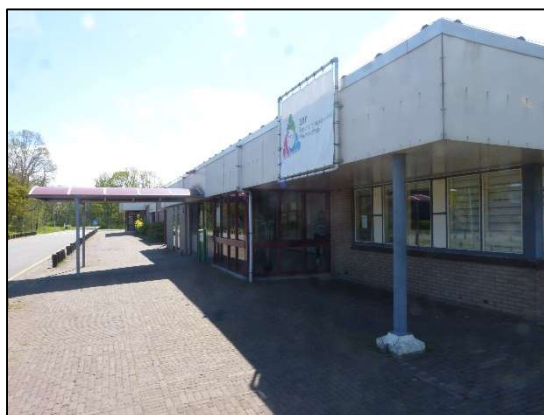
Afbeelding 2.17. Noordzijde van het U-vormige gebouw.
