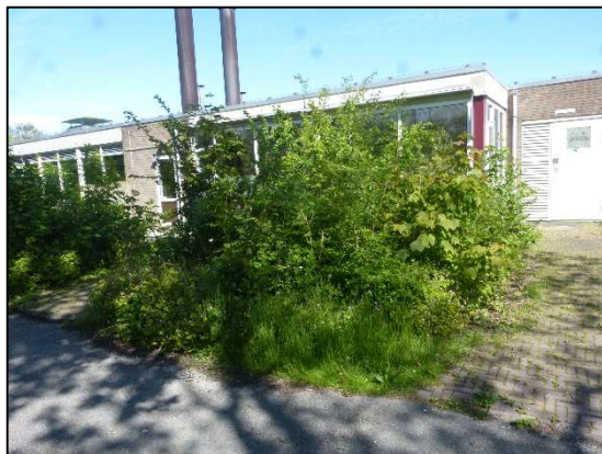
Afbeelding 2.20. Zuidzijde van het U-vormige gebouw.
