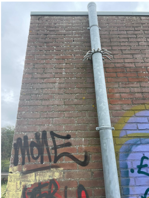
Fig. 3.10: Aanwezig gebouw met open stootvoegen.
