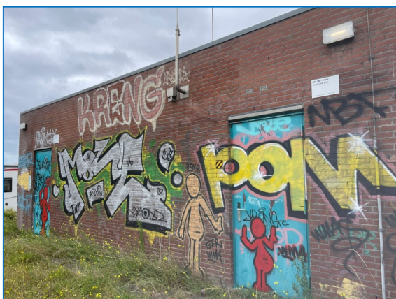
Fig. 3.6: Impressie van het plangebied. Zuidzijde van het gepland te slopen pand.
