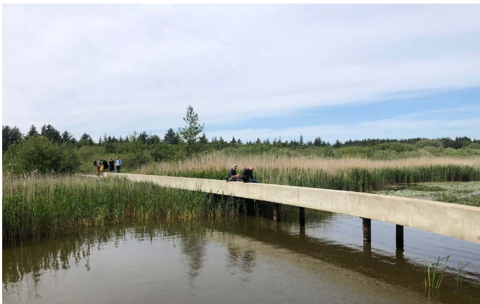
overbruggingen daar waar de routing water kruist
