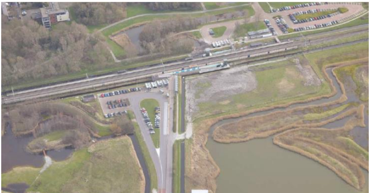
Afbeelding: weergegeven is het plangebied in de huidige situatie. Zichtbaar is de spoorlijn Den Helder-Alkmaar.
