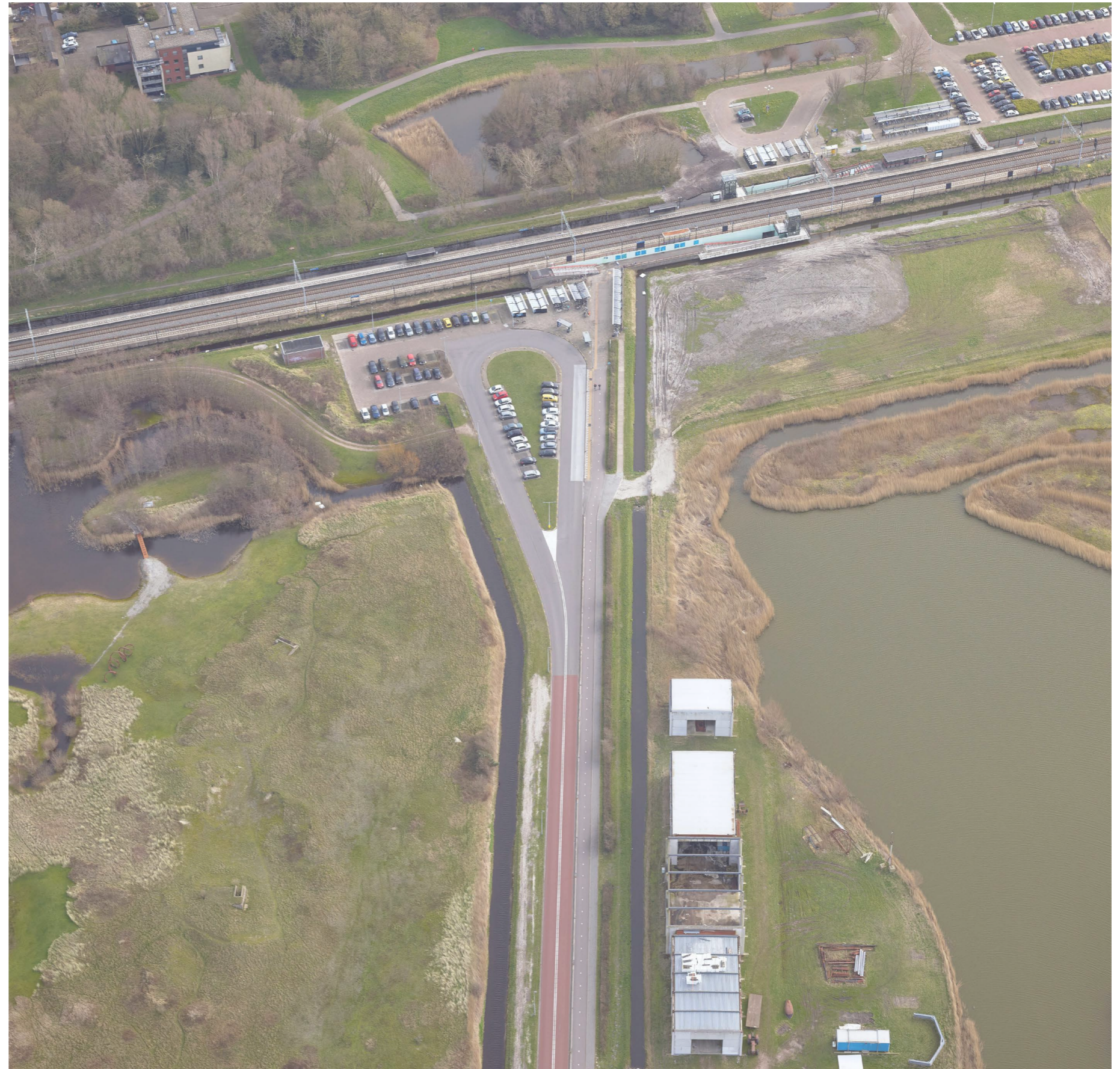
bestaande situatie met aan de bovenzijde de Schooten, en aan de onderzijde de Nollen met het nieuwe museum
