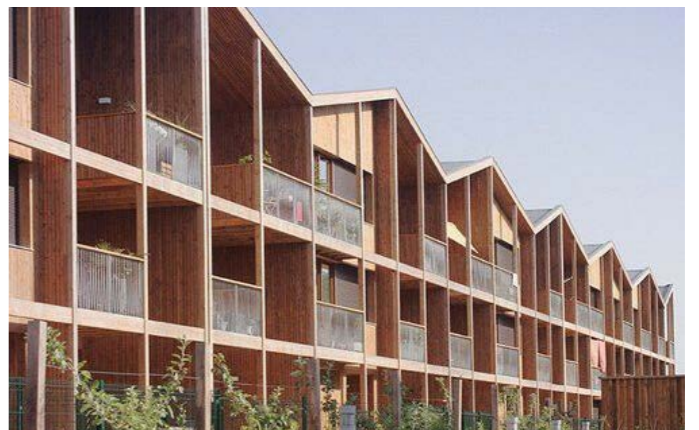
bijzondere dakvorm met plasticiteit in daklijn
