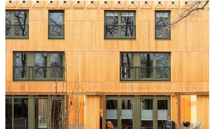
kozijnen / goten / overige details gebruiken een kleurtint uit het palet. deze vormt geen groot contrast met de gevelbekleding.
