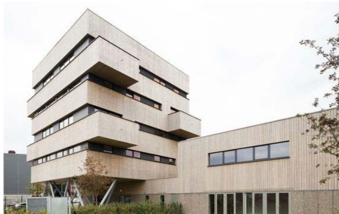
balkons zijn duidelijk onderdeel van de architectuur, maar mogen buiten de gevelrooilijn vallen
