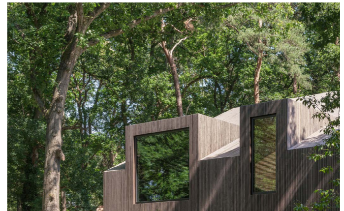
bijzondere dakvorm met plasticiteit in daklijn
