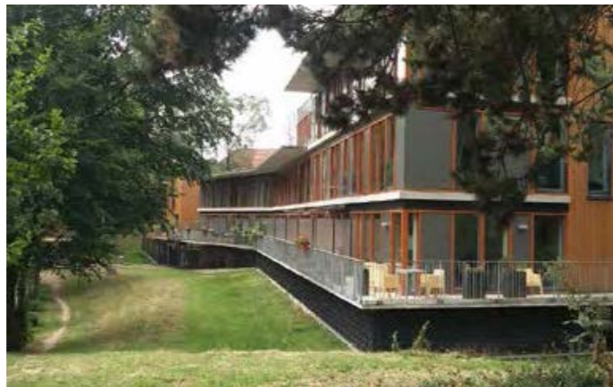
halfverdiepte parkeergarage onder de woning, de zone die hierboven ontstaat kan gebruikt worden voor balkons / galerijen
