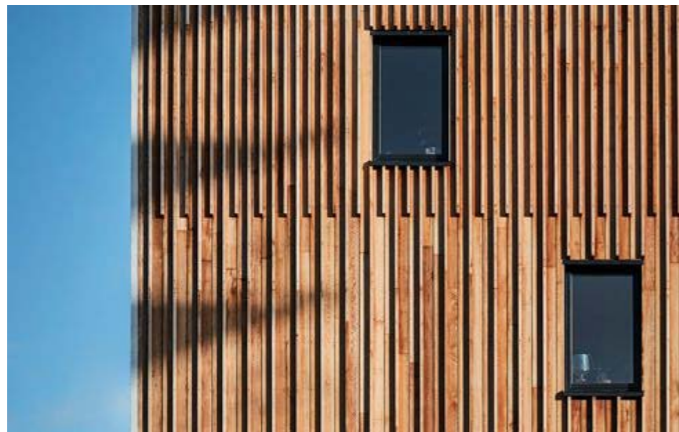
plasticiteit in de gevel door houten gevelbekleding met verschillende texturen toe te passen
