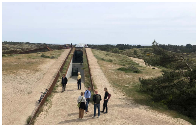
fietstunnel als 'ingesneden' element onderdeel van het landschap
