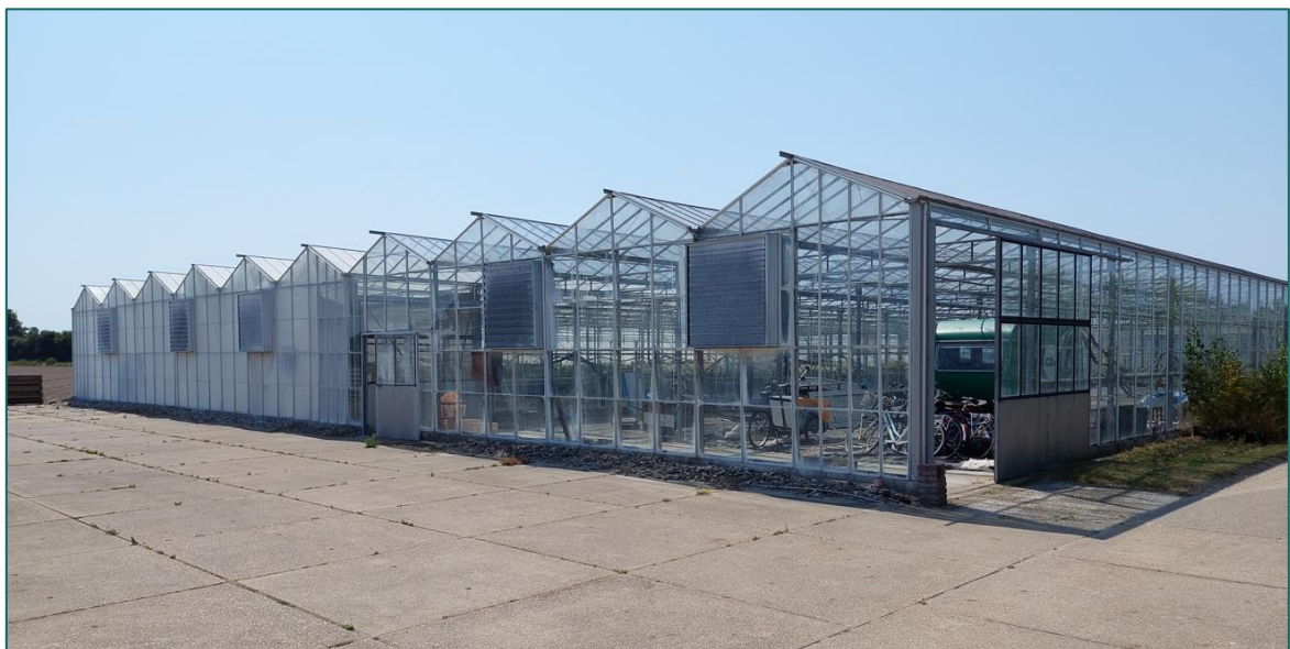
Figuur 1.3 Op de planlocatie is men voornemens om de kas te slopen ten behoeve van een woning.
