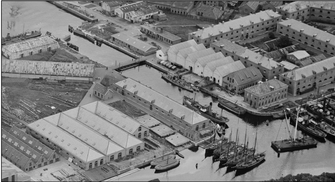
Afbeelding 3: uitsnede van de luchtfoto uit de vorige afbeelding. Het Boerenverdriet is in gebruik: de sluisdeuren staan gedeeltelijk open en de vlotbrug ligt over het Boerenverdriet.
