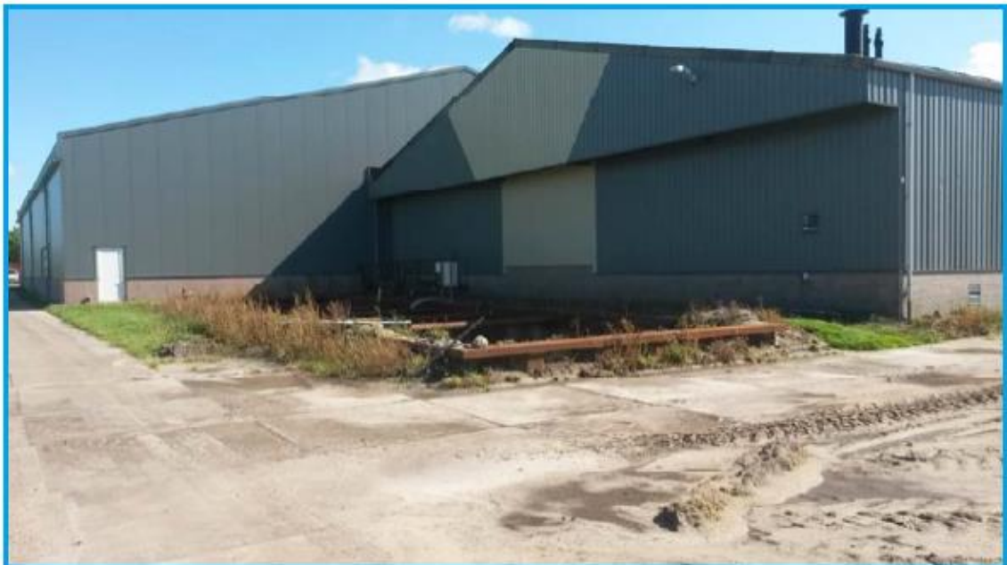
Figuur. Deel bedrijfsbebouwing achterzijde
