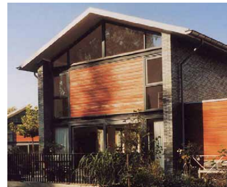
De woningen hebben een flauw hellend dak.
