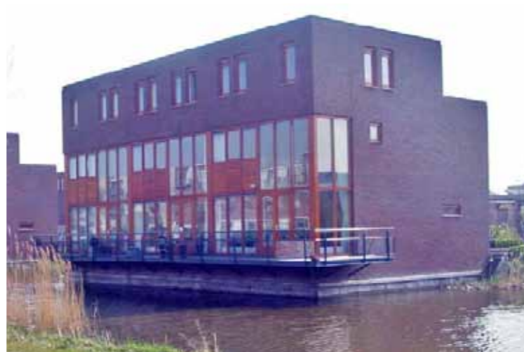
De gebouwen hebben een 'overhoekse' open oriëntatie aan het water.
