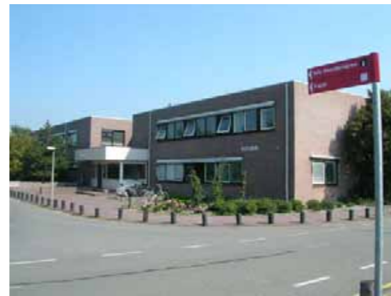
3. Centrale voorzieningen gebouw (Het Blok)
