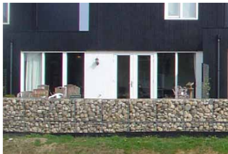
De erfafscheidingsen zijn meeontworpen met de architectuur van het gebouw.
