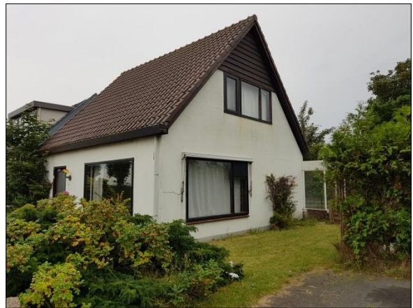
Figuur 4. Woning aan Schoolweg 20
