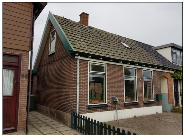
Figuur 6. Woning aan Schoolweg 24
