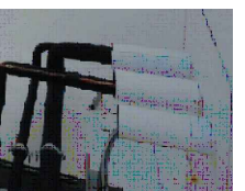
PRINCIPE MUURDOORVOER DAKBEDEKKING t.b.v. flexibele koelleidingen / bekabeling
