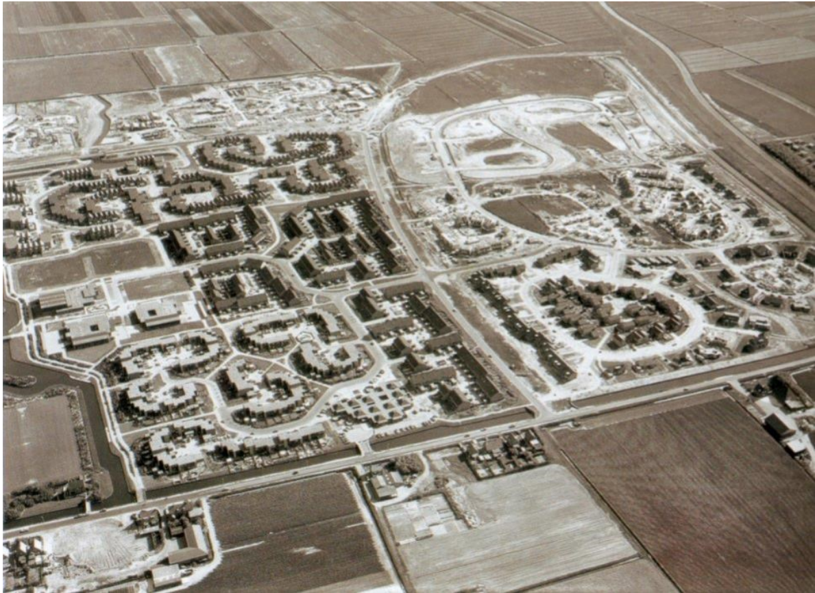
Julianadorp in aanbouw
