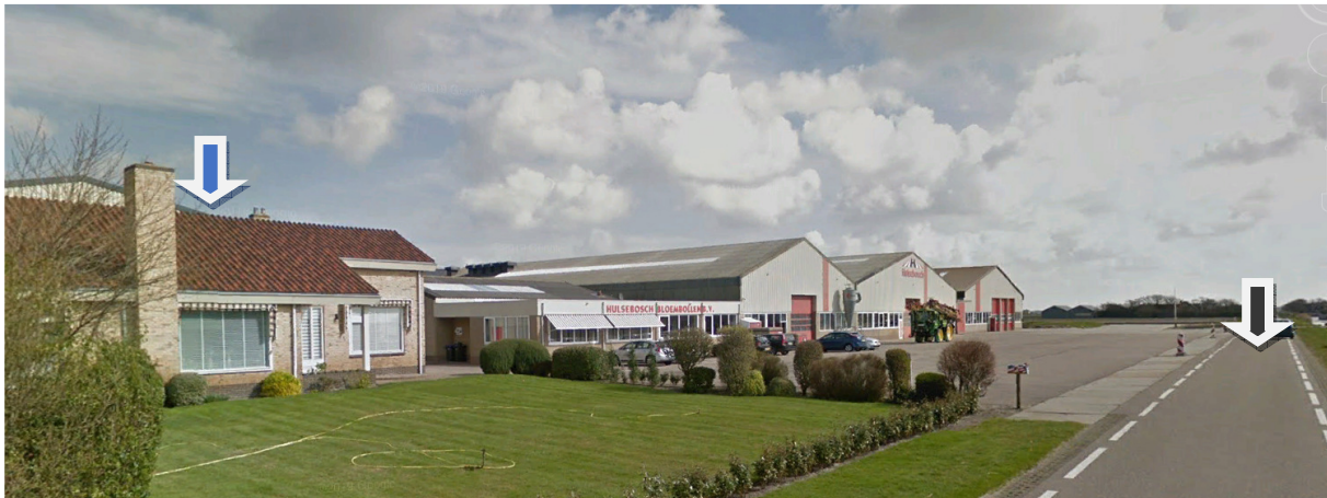
Bij de blauwe pijl de bestaande bedrijfswoning. De recent gerealiseerde uitbreiding (fase 1 en 2) is niet zichtbaar. Bij de zwarte pijl is de openbare weg Middenvliet gesitueerd, waarover de ontsluiting van de planlocatie plaatsvindt.
