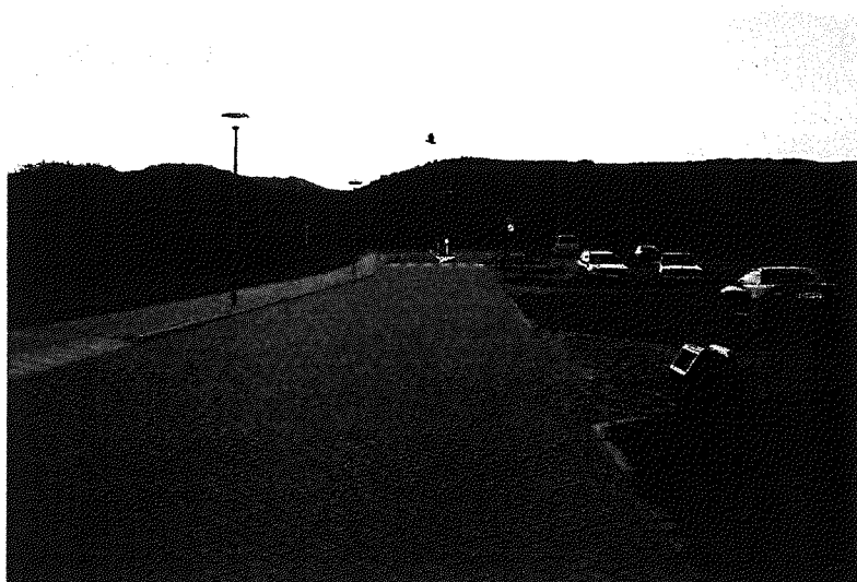
Foto bestaande uitrit
