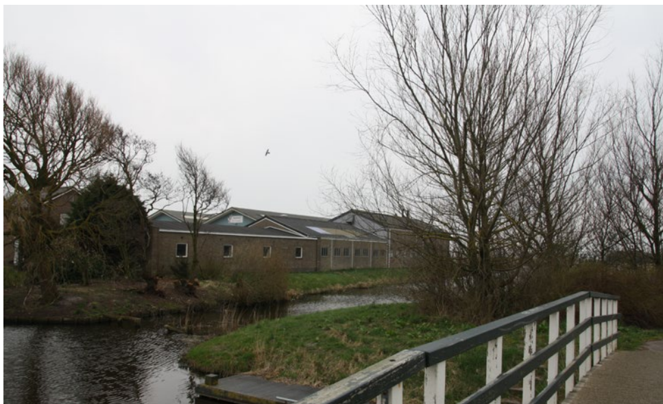
Stenen schuren van erf nr.2 vanaf de brug richting Mariëndal gezien.
