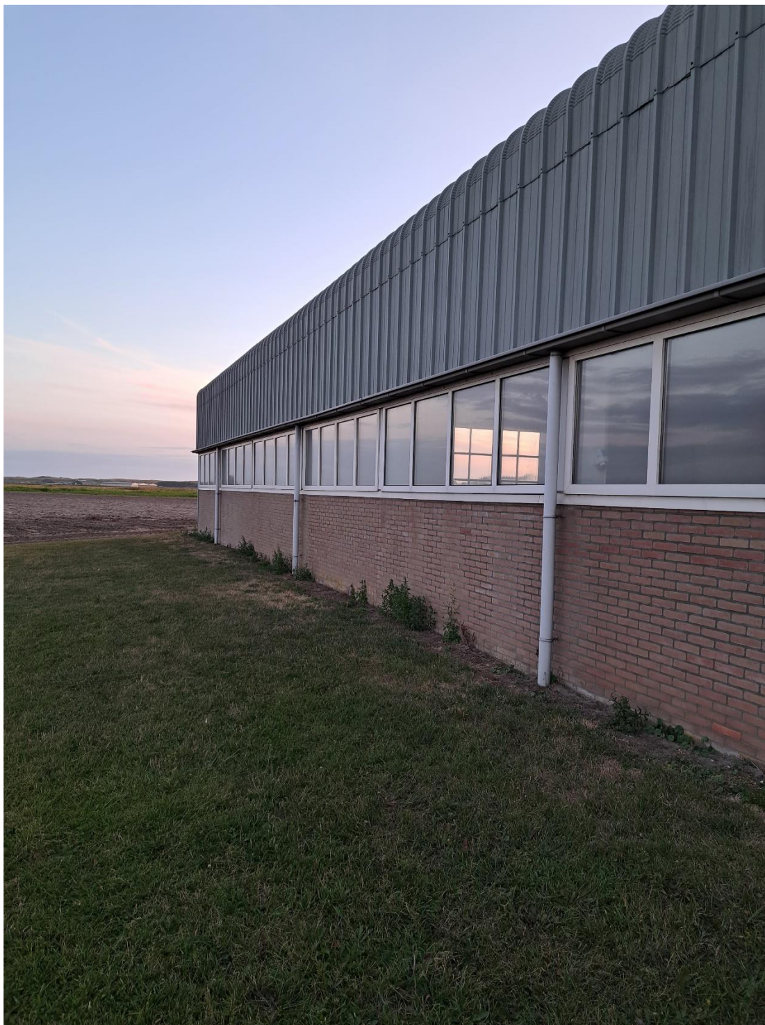
Enkelwandige schuren geen spouwmuur aanwezig
