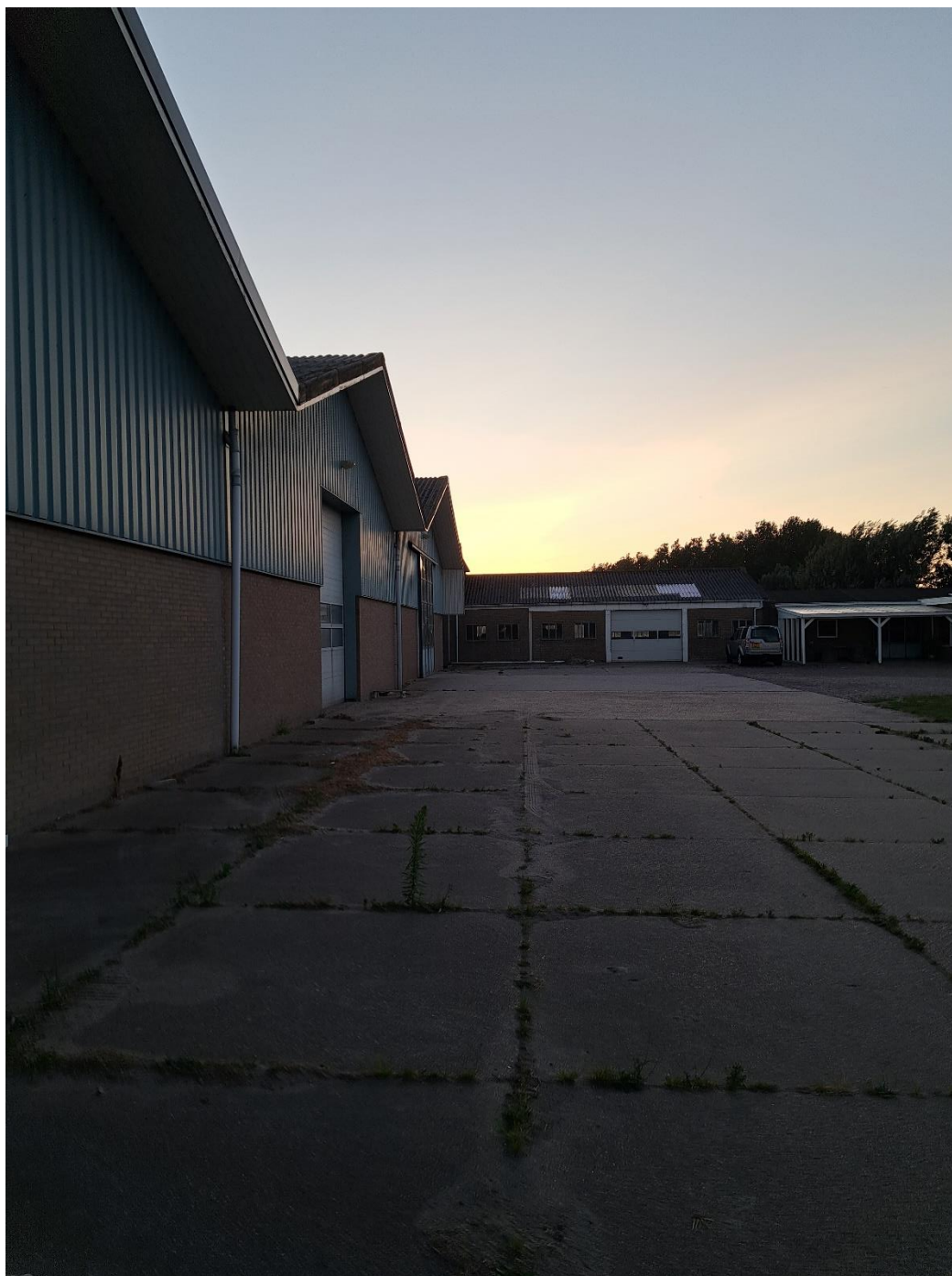
Schuren westkant plangebied geen spouwmuur aanwezig
