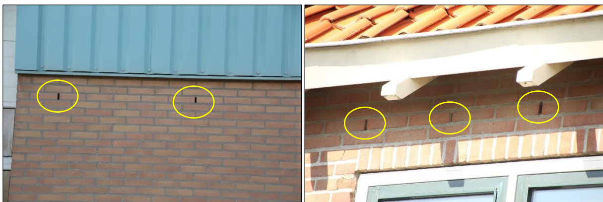
Open stootvoegen (gele cirkels) aangetroffen in de gevels van één van de loodsen en de woning op huisnummer 4.
