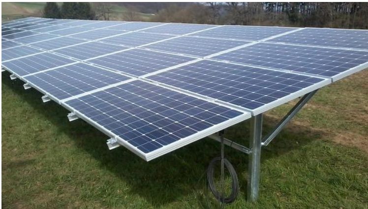
afb.5 Referentiebeeld compacte zuidopstelling
