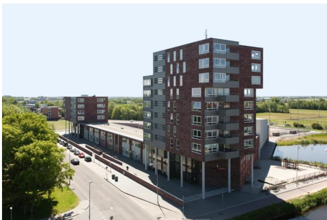
afb.16 Brede school IJsselmeerstraat (bron: Woningstichting Den Helder)
