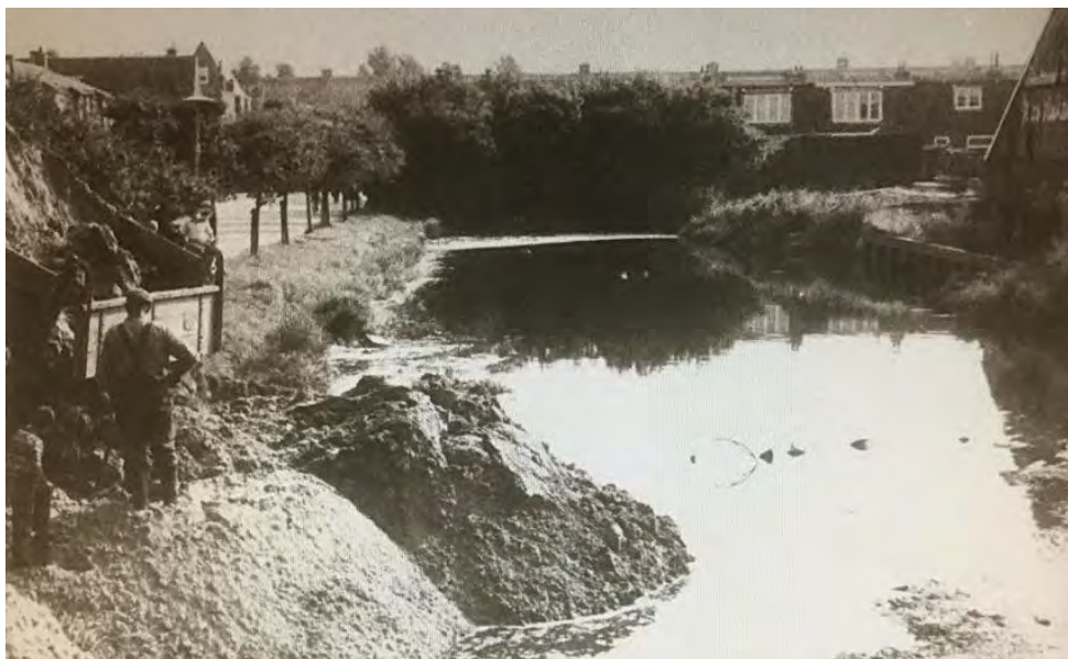
Foto's van de demping van de Fabrieksgracht, jaren '60
