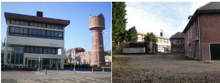
Voormalig postkantoor en watertoren. Achterzijde postkantoor, met bunker.
