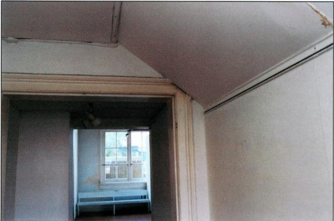
Afb. 24 [boven]: De achterwand van het lokaal linksvoor (BG) met restant van de scheidingswand.
