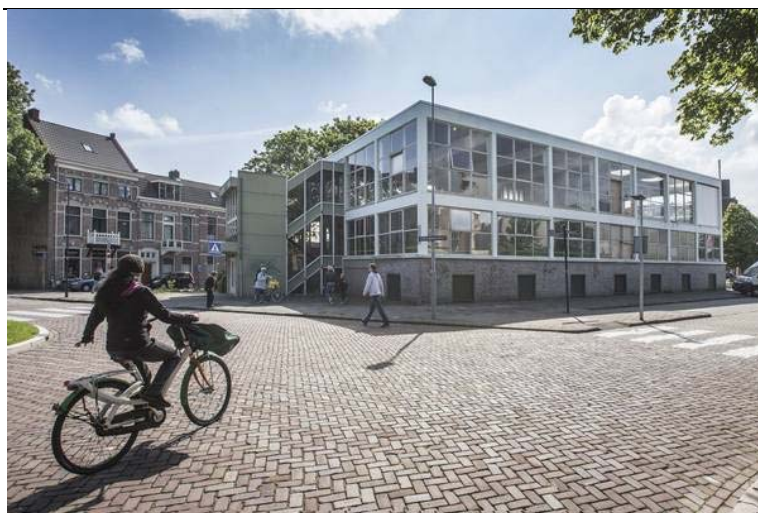
Figuur 2.1 Het - inmiddels gesloopte - VBM kantoor op de planlocatie
